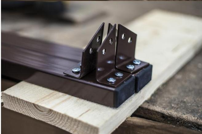
Прикрутить уголки крепления арок к несущим балкам с шагом, соответствующим региональной снеговой нагрузке и толщине поликарбоната (700 или 1050 мм).
