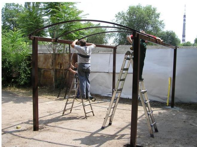
Установить арки на несущие балки, закрепив их в уголках 4-мя болтами М6\*50.
