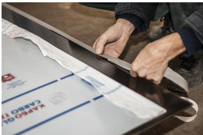
Заклеить торцы сотового поликарбонатного листа перфорированной лентой.
